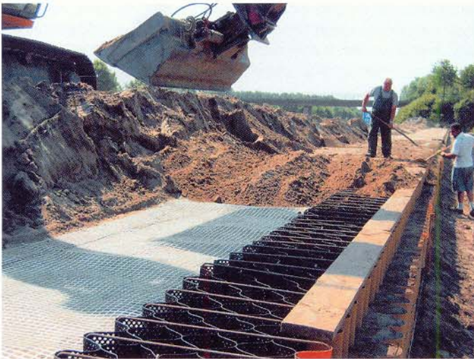
Beschüttung der Secugrid®-rückverankerten Geozellen
